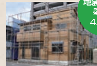
構造用ハイベストウッド(MDF)施工例
