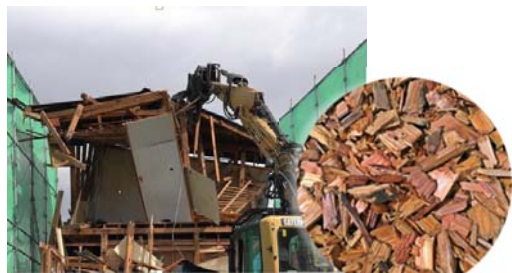
住宅解体作業等から出る廃木材チップ
